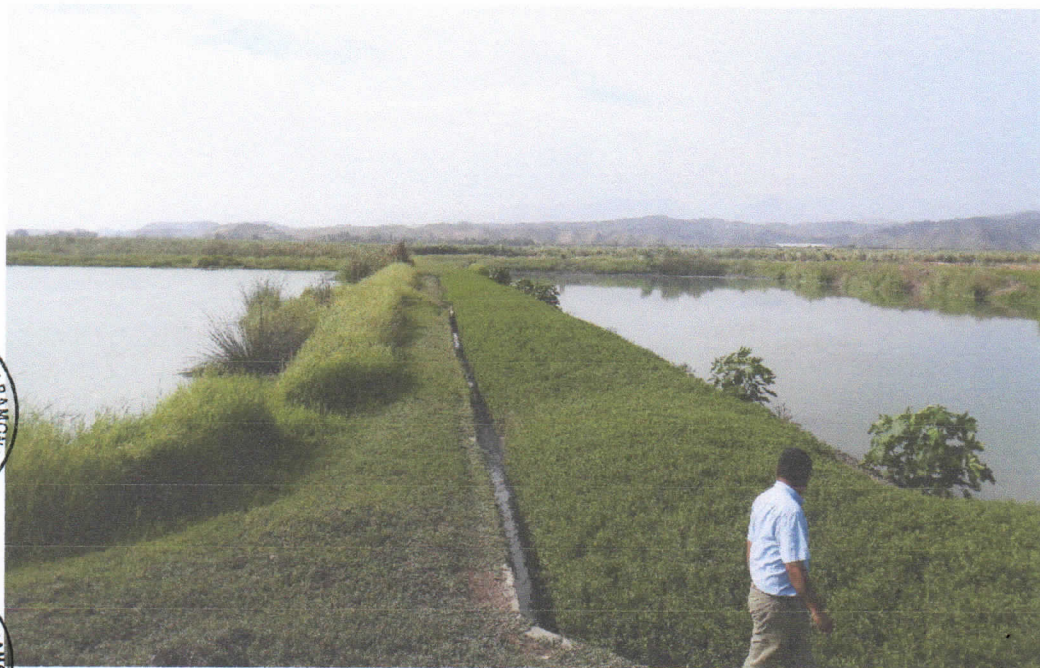
FOTOGRAFÍA N° 4.03: MANTENIMIENTO DE LAGUNAS DE OXIDACIÓN
